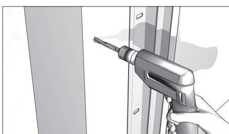
Просверлите отверстия Ø10 мм в стене проема. В отверстия забейте дюбели.
