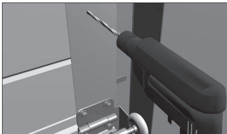
Просверлите отверстия  $\varnothing 4,2$  мм для крепления задвижки и отверстие  $\varnothing 15$  мм в угловой стойке для входления ригеля задвижки.
